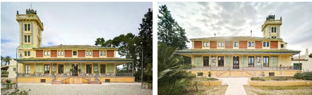
Fig. 6.73 // Fachada principal y fachada posterior de Torre Llagostera en Cartagena, El Plan. Fuente: fotografías realizadas por el autor.
