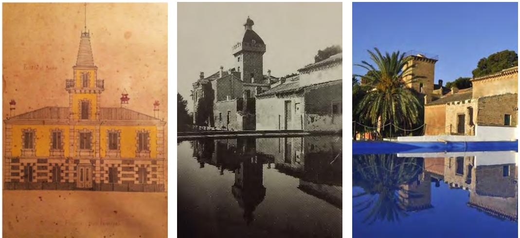
Fig. 6.59 // A la izquierda, Torre Nueva, en Cartagena, Pozo Estrecho. Fuente: Proyecto, año 1903. Al centro, Torre Nueva, en Cartagena, Pozo Estrecho. Fotografía h.1960. Fuente: cedida por la propiedad. A la derecha, Torre Nueva, en Cartagena, Pozo Estrecho. Fotografía año 2015. Fuente: Vacaciones España, Finca Moreno [Página web]. [Consulta 12 diciembre 2016] Disponible en: https://www.vacaciones-espana.es/12519
