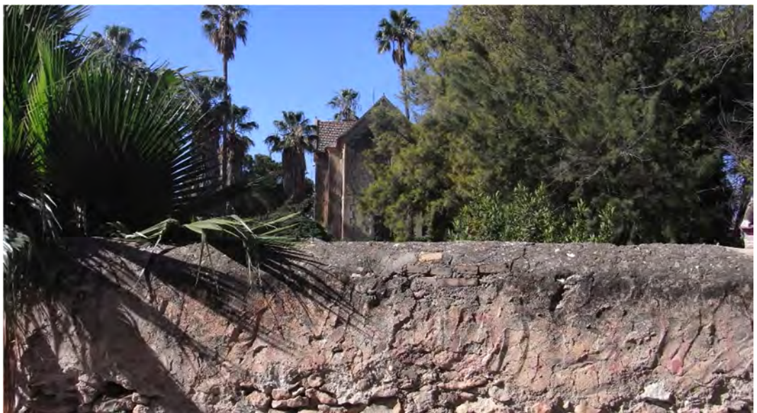
Fig. 6.85 // Muro de delimitación perimetral de Los Pinos en Cartagena, Pozo Estrecho. Fuente: fotografía realizada por el autor.
