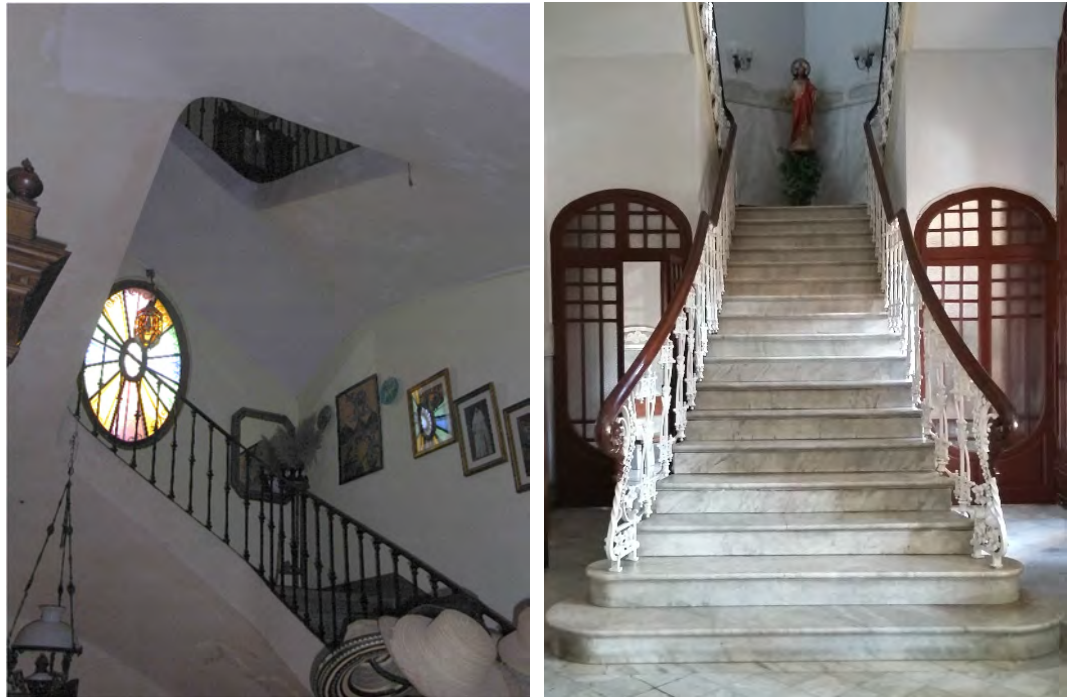
Fig. 6.86 // A la izquierda, escalera sobre bóveda tabicada de Los Pinos en Cartagena, Pozo Estrecho. A la derecha, escalera imperial de la Casa Zapata en Cartagena, Casco. Fuente: fotografías realizadas por el autor.
