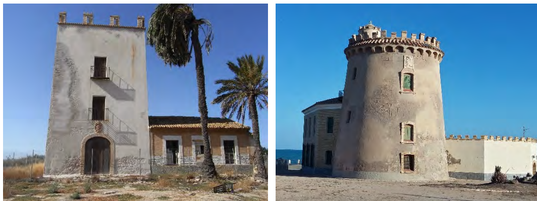
Fig. 7.39 // Torres defensivas. A la izquierda, Torre del Rame. Los Alcázares, Las Lomas del Rame, siglo XIII. A la derecha, Torre de la Horadada. Pilar de la Horadada, Torre de la Horadada año 1591. Fuente: fotografías realizadas por el autor.
