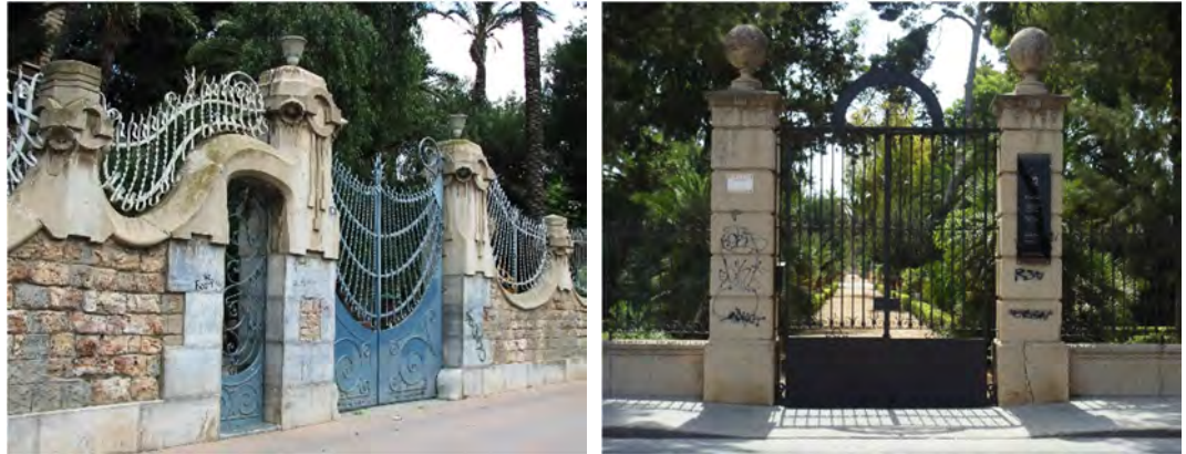
Fig. 6.26 // A la izquierda, vallado perimetral de la Casa Zapata, en Cartagena, Casco. A la derecha, vallado perimetral de la Torre Llagostera, en Cartagena, El Plan. Fuente: fotografías realizadas por el autor.
