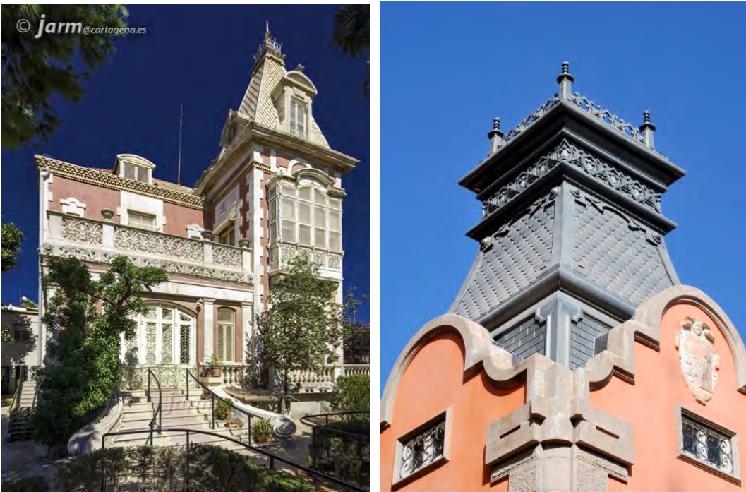
Fig. 6.91 // A la izquierda, chapitel de cinc del chalet de Enriqueta Soler en Cartagena, San Antonio Abad. Fuente: fotografía cedida por José Antonio Rodríguez Martín. A la derecha, chapitel de cinc del Palacio Riquelme en Cartagena, Casco. Fuente: fotografía realizada por el autor.
