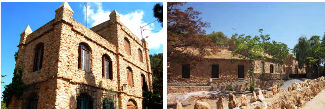
Fig. 6.68 // Residencia principal y construcciones de servicio de El Inglés, en Cartagena, Perú. Fuente: fotografías realizadas por el autor.
