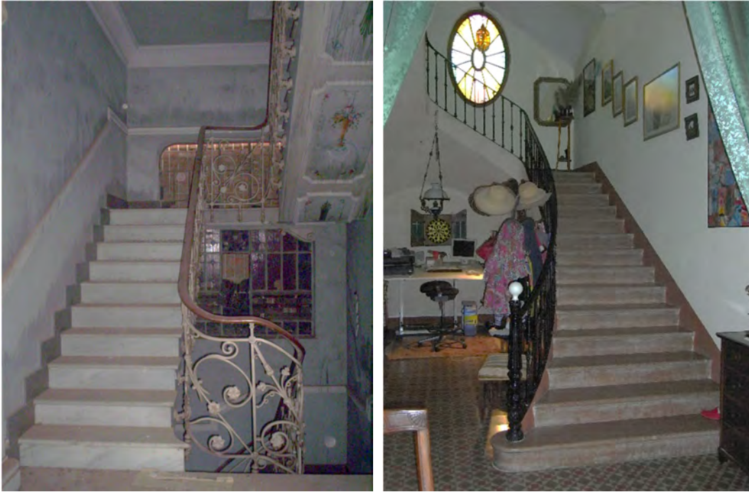
Fig. 6.43 // A la izquierda, escalera principal de Villa Calamari, en Cartagena, San Félix. A la derecha, escalera principal de Los Pinos, en Cartagena, Pozo Estrecho. Fuente: fotografías realizadas por el autor.
