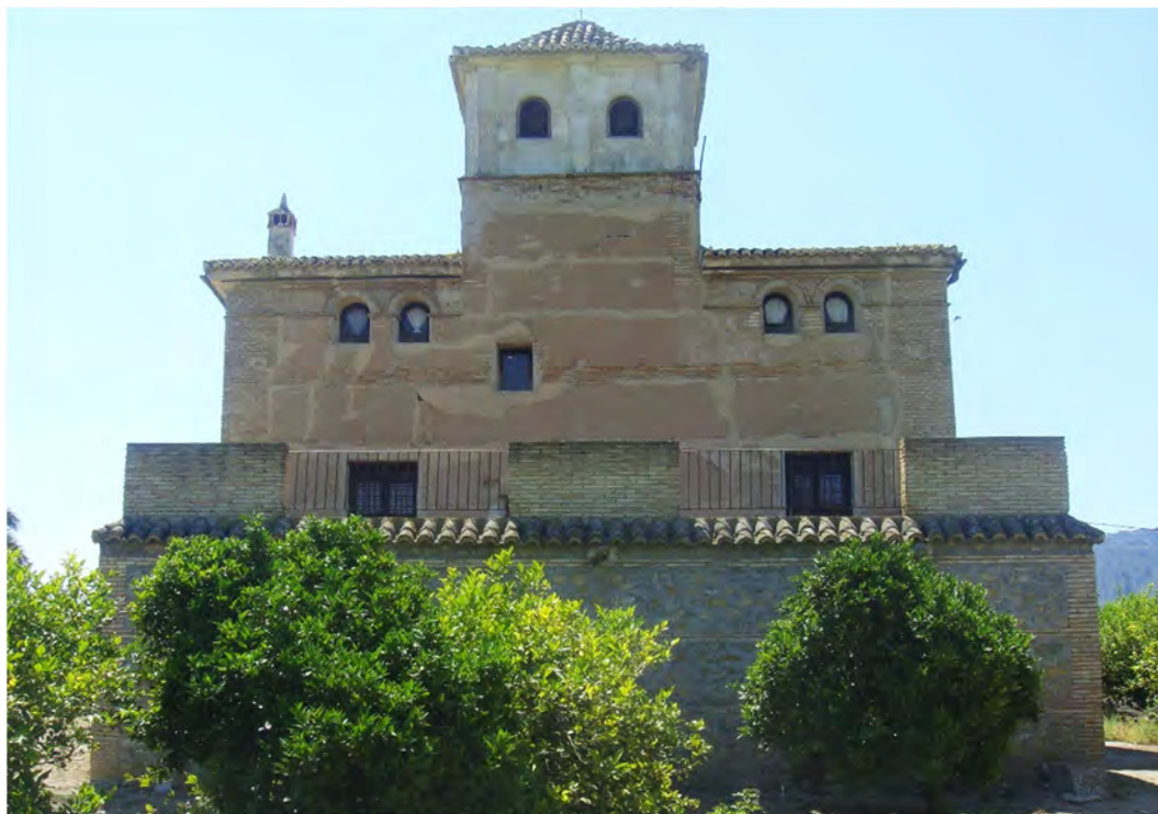
Fig. 5.17 // Ejemplo de casa torre de la huerta de Murcia. Fuente: fotografía realizada por el autor.
