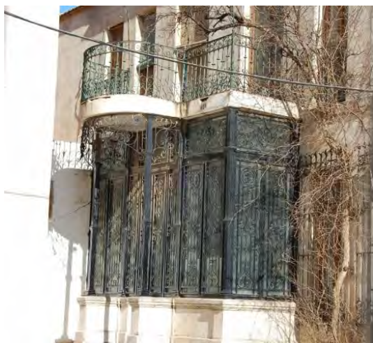
Fig. 6.62 // Acceso a la capilla de Huero Berizo, en Cartagena, San Antonio Abad. Fuente: fotografía realizada por el autor.
