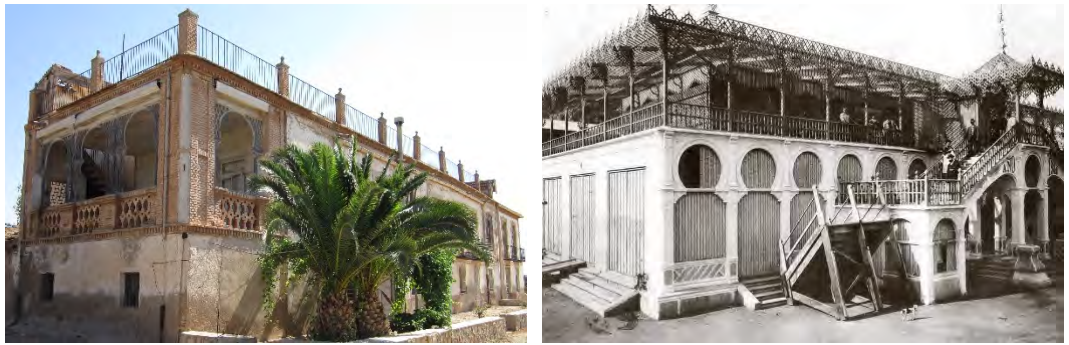
Fig. 6.77 // A la izquierda, porche de la Villa Lo Triviño en Cartagena, La Palma. Fuente: fotografía realizada por el autor. A la derecha, balneario de San Bernardo, en Cartagena. Fuente: Cartagena Antigua [Blog]. [Consulta: 20 octubre 2016] Disponible en: https://cartagenaantigua.wordpress.com/tag/san-bernardo/
