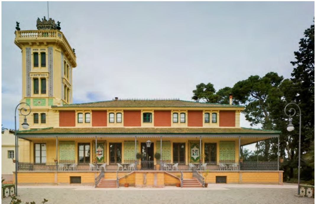
Fig. 5.26 // Fachada principal de Torre Llagostera. Cartagena, año 1918. Fuente: fotografía realizada por el autor.
