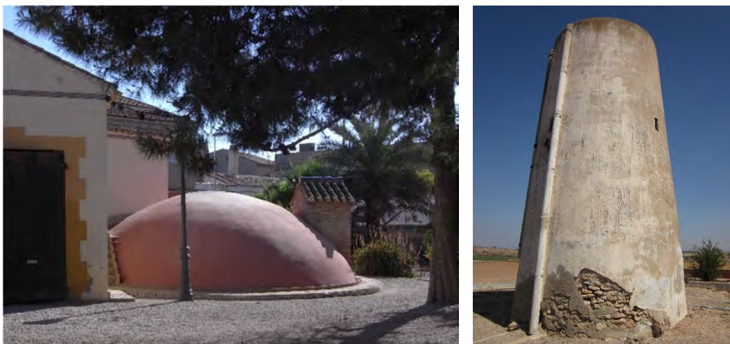
Fig. 6.13 // A la izquierda, aljibe de la villa denominada Los Pinos en Cartagena, Pozo Estrecho. A la derecha, molino de viento de la finca La Rosa. Cartagena, La Palma. Fuente: fotografías realizadas por el autor.
